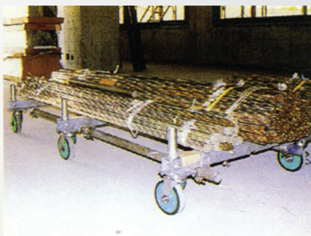
天井吊金物のストックヤード (積載量に合わせた6輪車)
