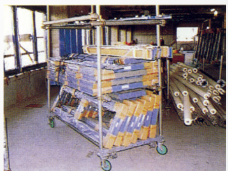
窓枠のストックヤード (足場単管を利用した2段式台車)
