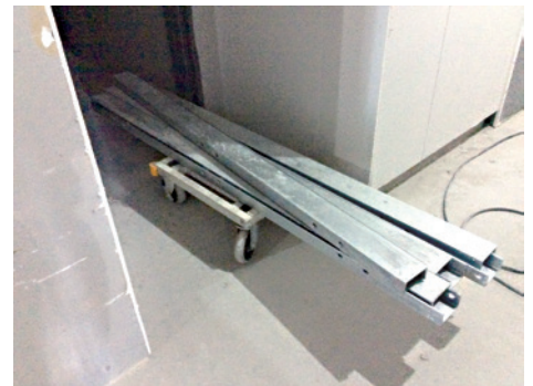
使用例(建設現場)
