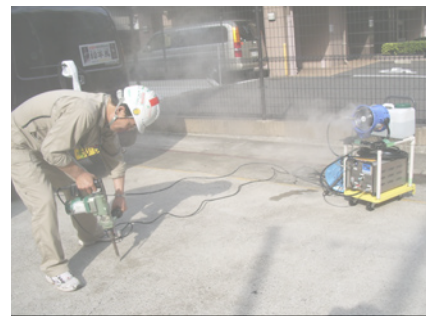
ハツリ工事の打撃音軽減
