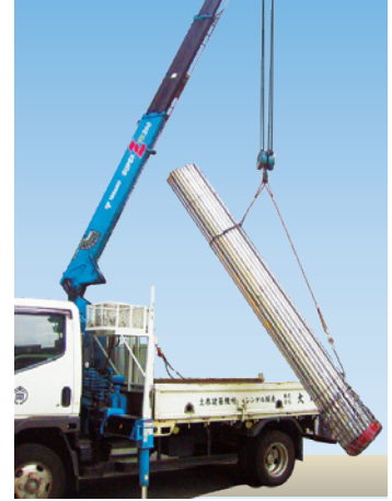
■ 使用例 (建設現場)
