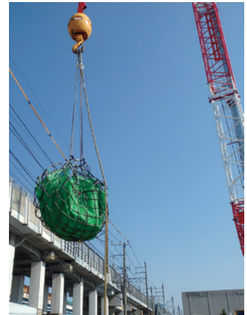
■ 使用例 (建設現場)
